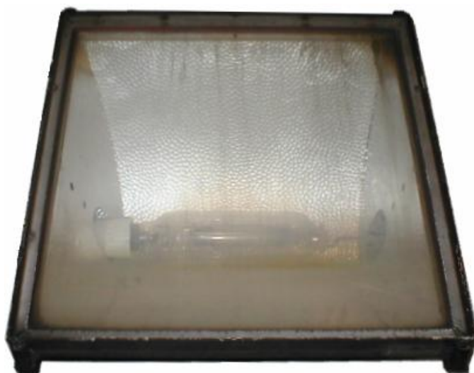
Obr. 9.6 – původní stav vybraného svítidla SIEMENS 5NA 715 s výbojkou TESLAMP RVI 3500 W
